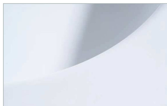
Akrylát po opravě
